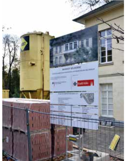
Nicht zu übersehen: Baustelle Bahnhof Belvedere
